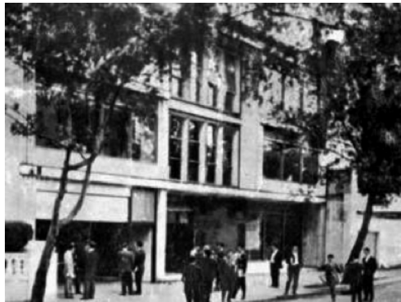
Fotografía 1. Facultad de Ingeniería, sede central, 1983
