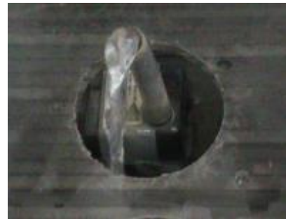
Figura 3. Sistema de Bombeo
