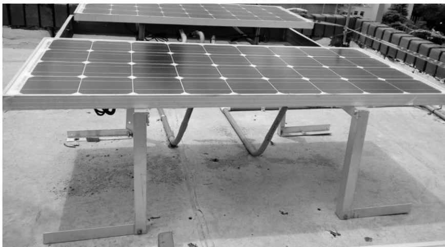
Figura 5 Superficie Estándar (hormigón). Fuente: elaboración propia de los autores.
