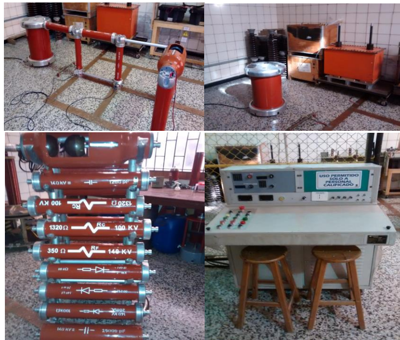
Figura 6. Laboratorio de alta tensión, iluminación y máquinas eléctricas Fuente: Subcomité de autoevaluación y acreditación Ingeniería Eléctrica
