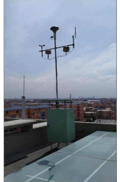
Fuente: Laboratorio de Calidad del Aire.
