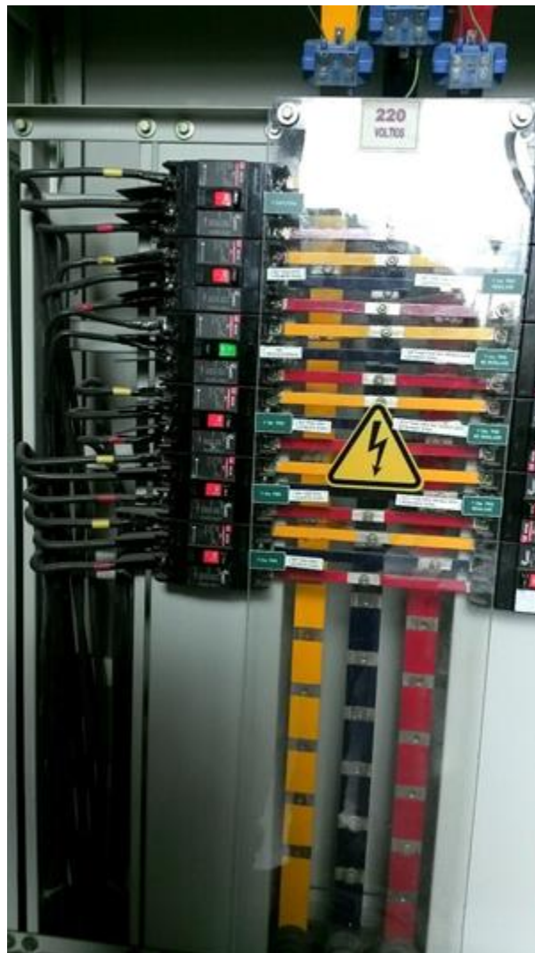
Figura 9. Tablero Subestación de la sede Vivero
