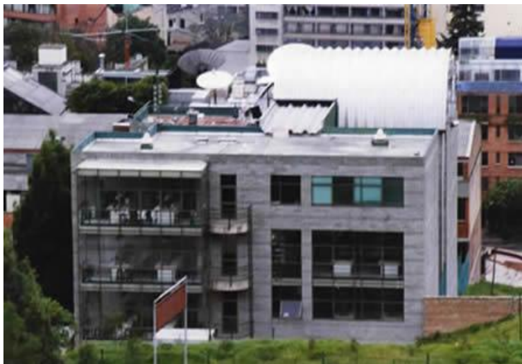
Figura 75. Arquitectura sede Macarena B
