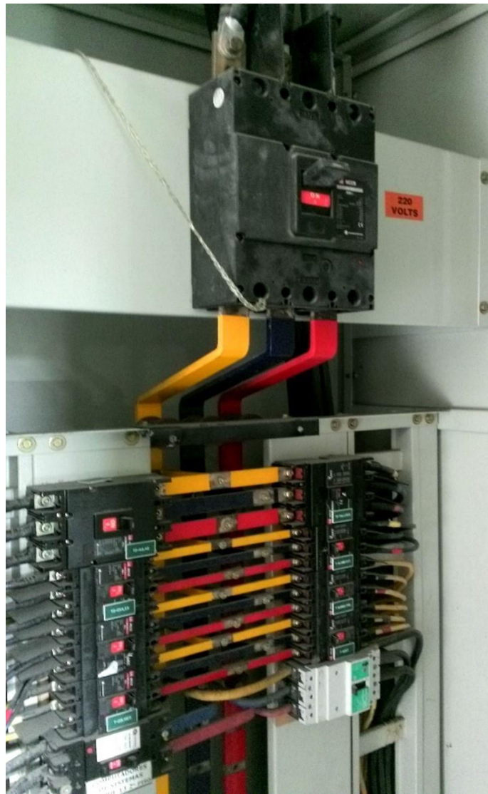
Figura 34. Tablero Subestación de la sede tecnológica
