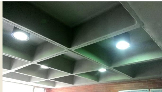
Figura 25. Sistemas de iluminación con obstáculos en techos
