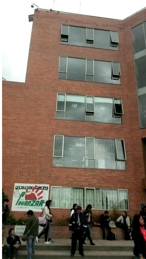
Figura 6. Edificación de la sede Vivero
